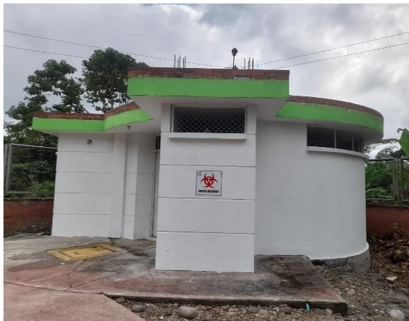
Ilustración 11.- Central de almacenamiento de residuos peligrosos.
